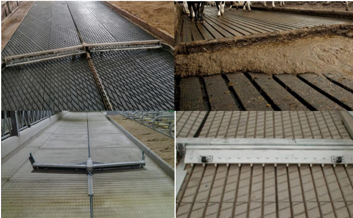
Figuur 1: Dichte stalvloeren met mestschuiven.
